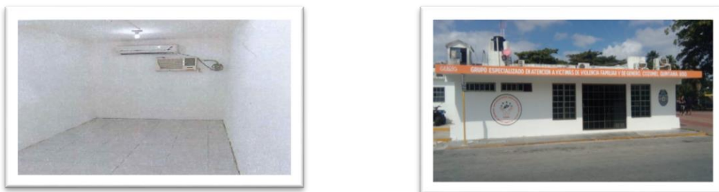
FIGURA 5. EVIDENCIA FOTOGRÁFICA DE LAS ADECUACIONES REALIZADAS.
