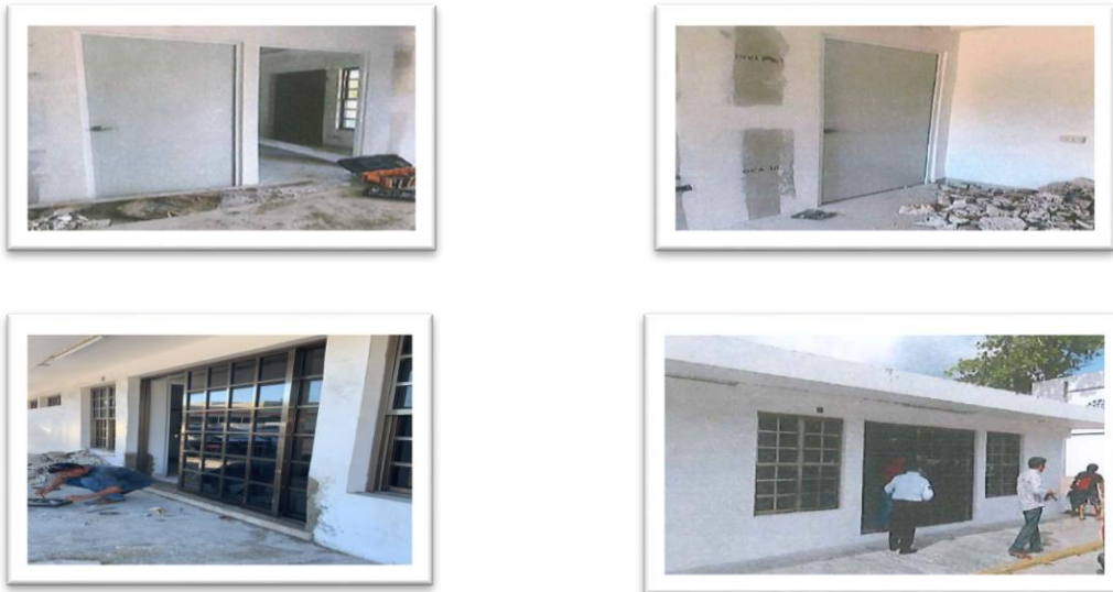
FIGURA 4. EVIDENCIA FOTOGRÁFICA DE LAS INSTALACIONES ANTES DE LAS ADECUACIONES.
